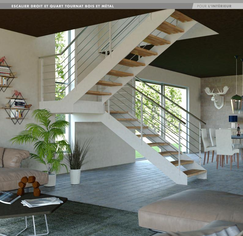
**STRUCTURE** : composée de doubles limons latéraux en acier de 8 mm
